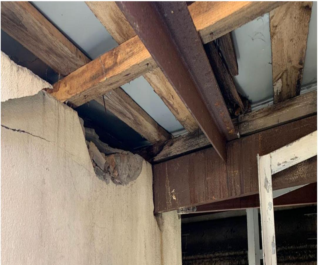
Фото 1.3. Коррозия элементов металлического каркаса
