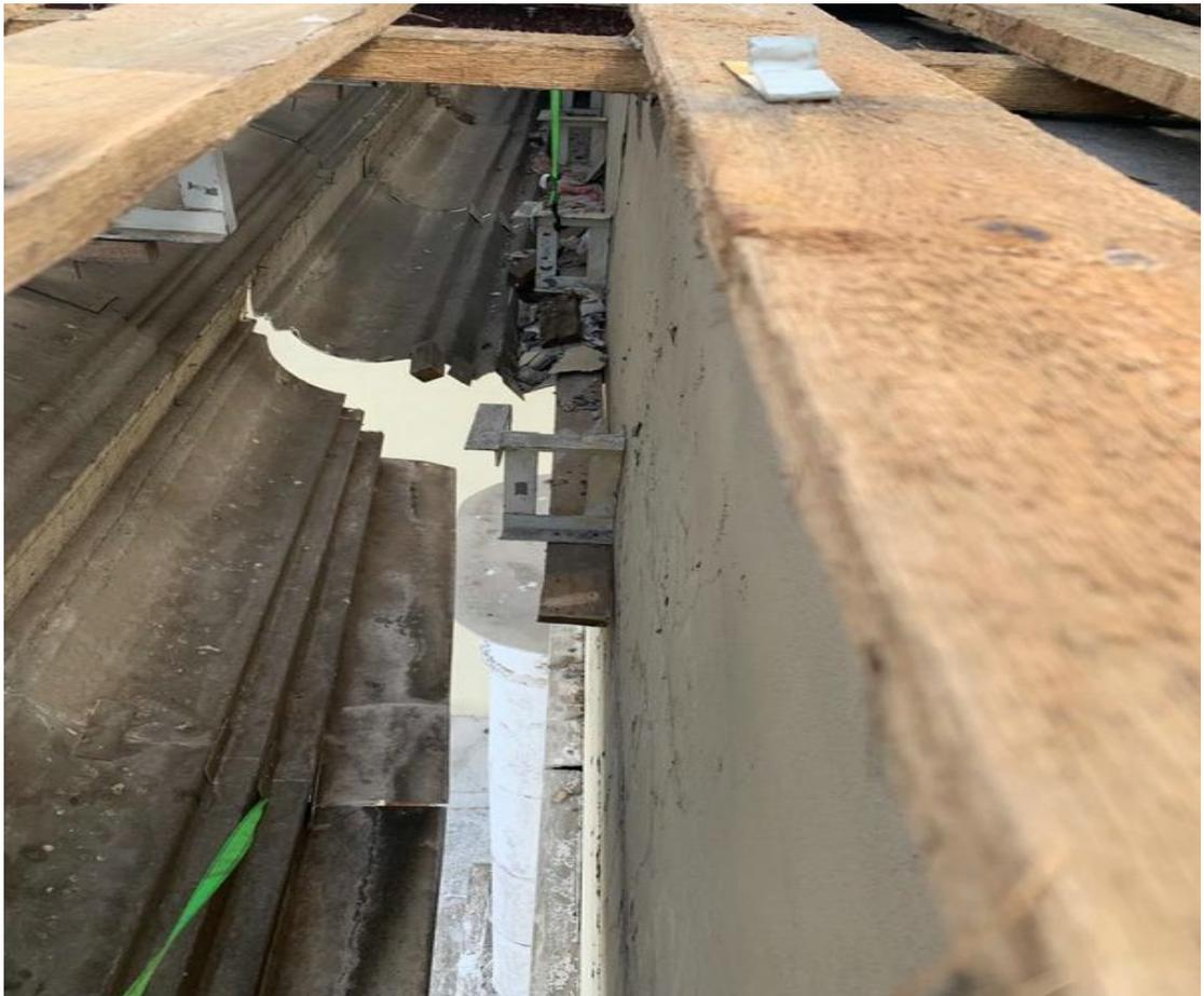
Фото 1.4. Разрушение соединений декоративных элементов стеклопластика
