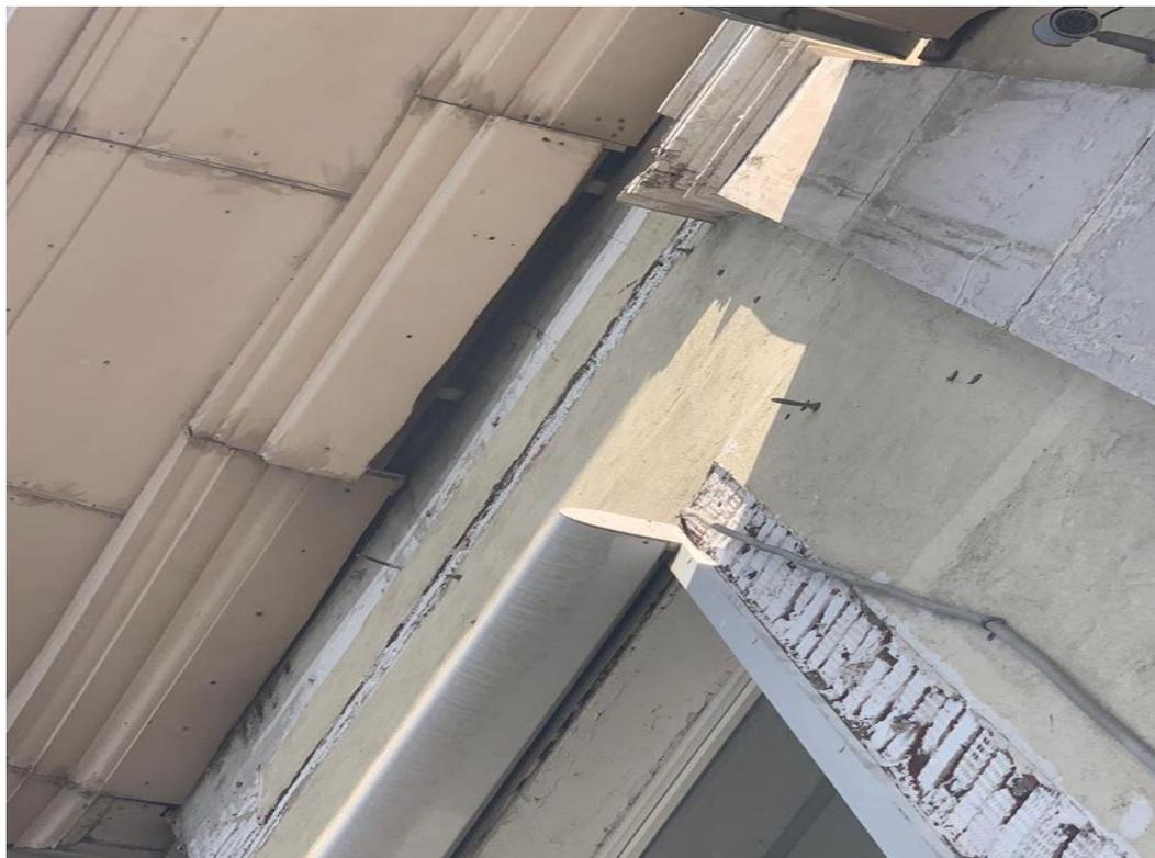
Фото 1.8. Разрушение крепления нижней части карниза к каркасу
