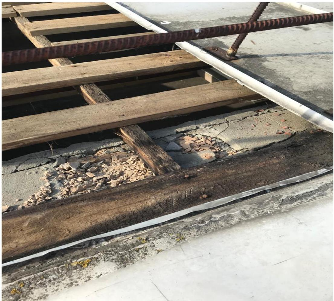
Фото 1.5. Сгнившие элементы древесины обрешётки
